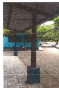
Foto 16. PRIMER MÓDULO DE AULAS "Sustitución de estructura de soporte metal"
