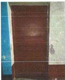
Foto 17. PRIMER MÓDULO DE AULAS "Mantenimiento a estructura (Lijado, cambio de tubo, cepillado, sujeciones, aplicación de pintura)"
