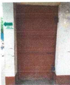
Foto 15. MÓDULO DE LABORATORIO INED "Sustitución de Puertas de Laboratorio INED"
