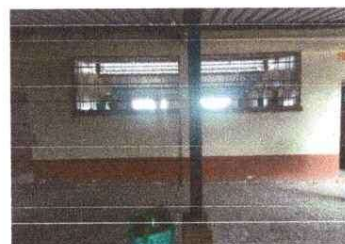
Foto 18. PRIMER MÓDULO DE AULAS "Pintura en muro interiores y exteriores"
