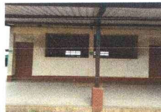
Foto 14. MÓDULO DE LABORATORIO INED "Pintura en muro interiores y exteriores"
