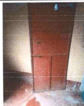
Foto 8. MÓDULO DE SANITARIO DIRECCIÓN INED "Sustitución de puerta de servicio sanitario"
