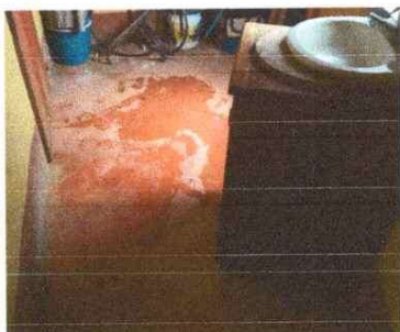
Foto 9. MÓDULO DE SANITARIO DIRECCIÓN INED "Sustitución de piso cerámico"
