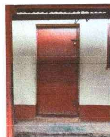
Foto 4. MÓDULO DE DIRECCIÓN INED. "Sustitución de Puerta de metal"
