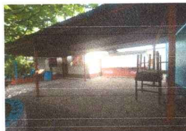
Foto 2. MÓDULO DE SALÓN INED "Sustitución de estructura de soporte de metal por metal"
