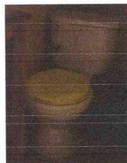
Foto 10. MÓDULO DE SANITARIO DIRECCIÓN INED "Sustitución de inodoro"
