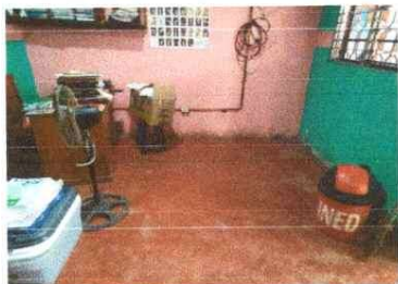
Foto 7. MÓDULO DE DIRECCIÓN INED "Pintura en muro interiores y exteriores"
