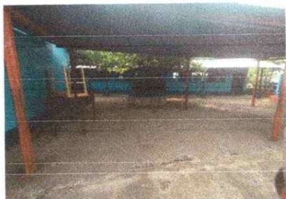
Foto 3. MÓDULO SALÓN DE INED "Sustitución de piso de torta de concreto"
